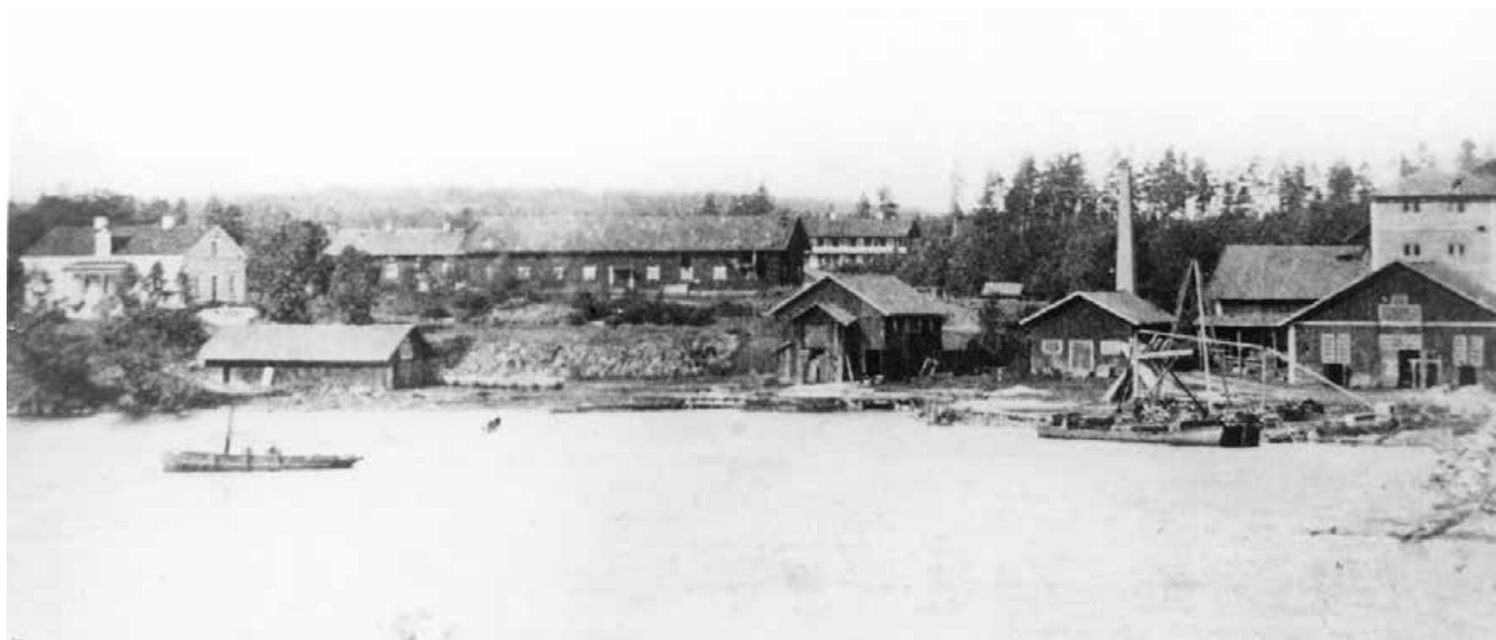
Trummelsbergs bruk med nya hyttan från ca 1890. Man ser från vänster förvaltarbostaden som finns kvar idag. Masugnen är den höga byggnaden längst till höger. Den låga delen till vänster om masugnen innehöll malmkross och blåsmaskin som båda drevs av vattenkraften. Ej i bild till höger om masugnen fanns rostugnen, och bakom den, det enorma kolhuset.
